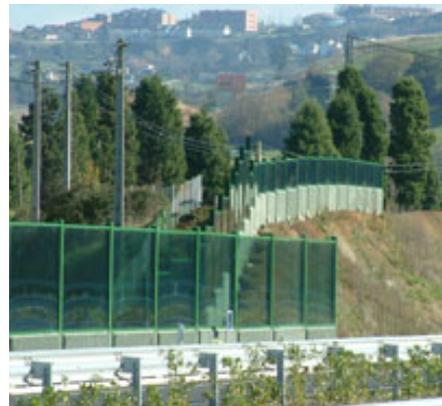
Las pantallas opacas, reflectoras o absorbentes, se utilizan corrientemente. Sin embargo, estos muros continuos y opacos, elevados en zonas urbanas constituyen un freno para la propagación de la luz y una limitación del espacio visual, que los vecinos consideran a menudo como una causa de estrés. Para evitar esta impresión de encarcelamiento, se pueden utilizar pantallas antirruido transparentes, denominadas corrientemente "ventanas".
